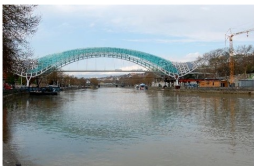
4. Pont de la Paix, Tbilissi(L.-A. Le Moulec, 2010).
