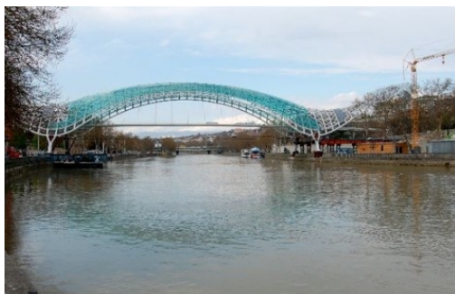
4. Pont de la Paix, Tbilissi(L.-A. Le Moulec, 2010).
