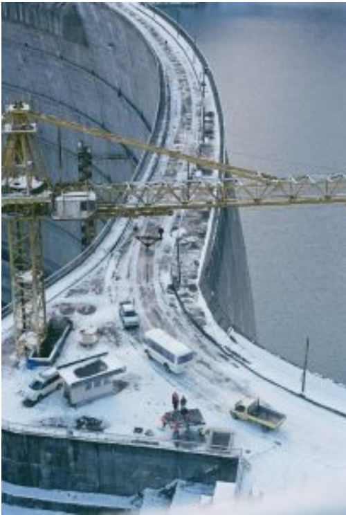
Le barrage de Jvari (photo Zadig Tisserand, 2020).
