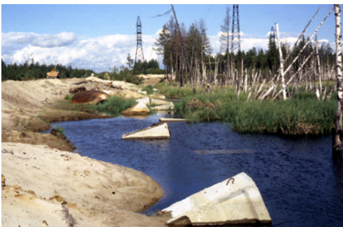
Oléoduc flottant dans une dépression thermokarstique © Yvette Vaguet
