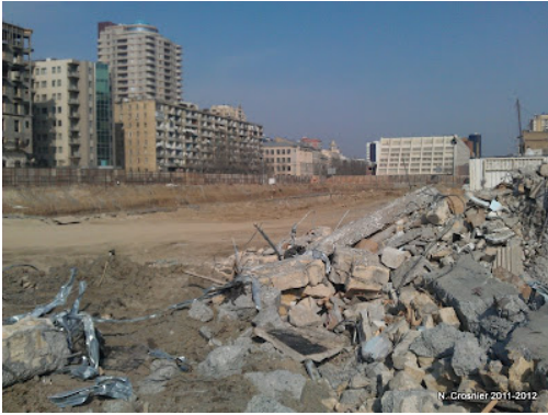
Le chantier du jardin d'hiver sur la rue Füzuli, Nicolas Crosnier, 2012.
