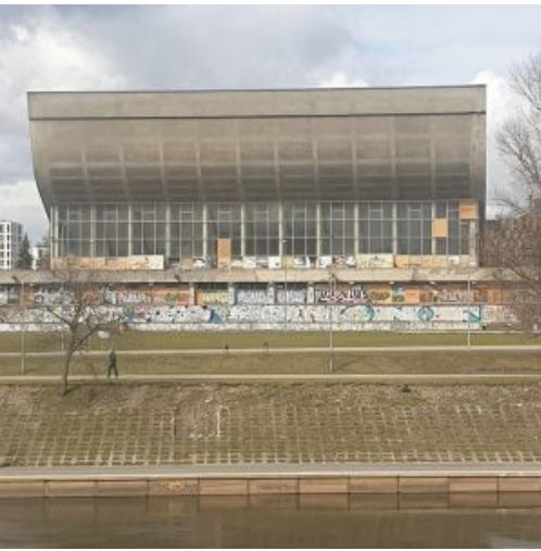
Façade avant d'ouverture et toiture du Sporto RÅ«mai.
