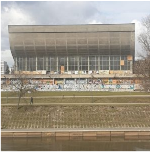
Façade avant détériorée et taguée du Sporto R?mai.
