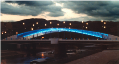
Le pont après sa reconstruction (photo Eric Grenier, 2001).
