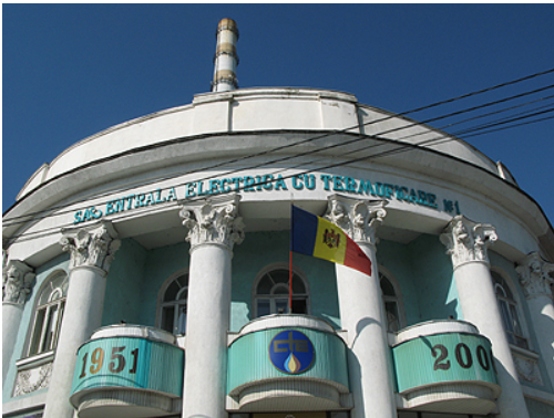
La centrale thermoélectrique CET-1 de Chisinau Photo: Gonzague Flutsch
